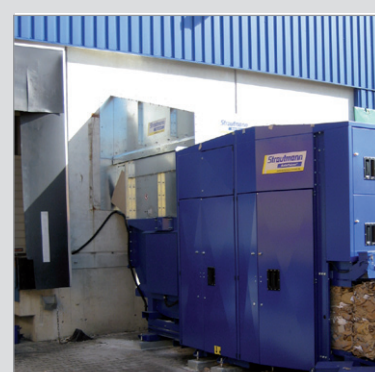
Külső telepítés fali nyíláshoz csatlakozással
